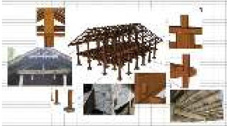
Gambar 8. Detail Sistem Sambungan Rumah Tradisional daerah pegunungan
