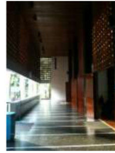
Gambar 3: Serambi dan dinding krawang (Sumber Foto: Dewiyanti, 2011)
