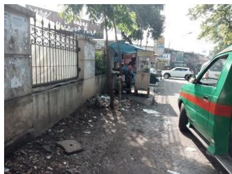
Gambar 2. Bentuk material trotoar yang tidak terawat.
