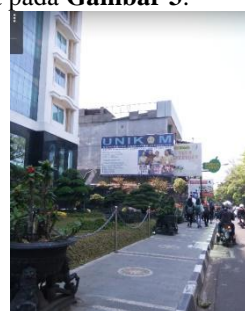
Gambar 3. Bentuk material trotoar yang terawat.
