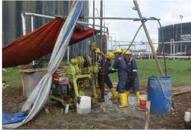
Kegiatan pemasangan casing dititik BH-02 Lok. Tangki 106 Pakning
