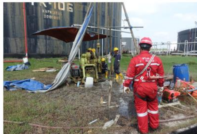
Kegiatan pengeboran dititik BH-02 Lok. Tangki 106 Pakning
